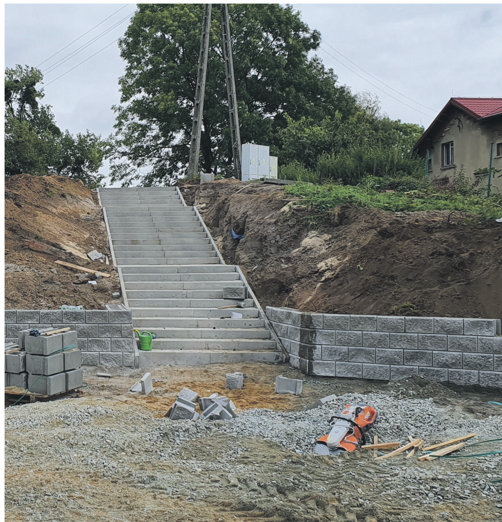
■ Trwają intensywne prace budowlane na terenie
